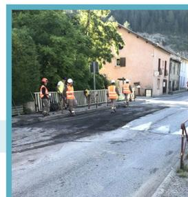
Les travaux de réfection et de création du **trottoir de Pont-Lagrand** se terminent. L'entreprise COLAS a réalisé les enrobés sur le trottoir et la tranchée du réseau d'eau début juillet.
